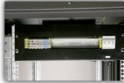
Bornier de raccordement situé à l'arrière de la baie
