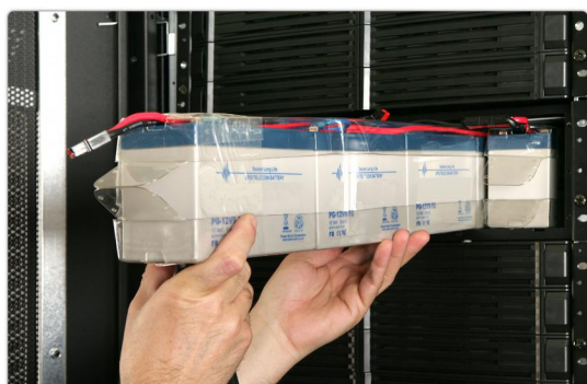
Remplacement d'une rangée de batteries
