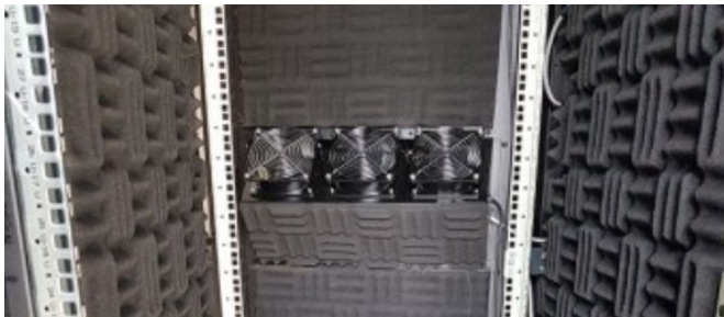
Ventilation silencieuse et pièges acoustiques
